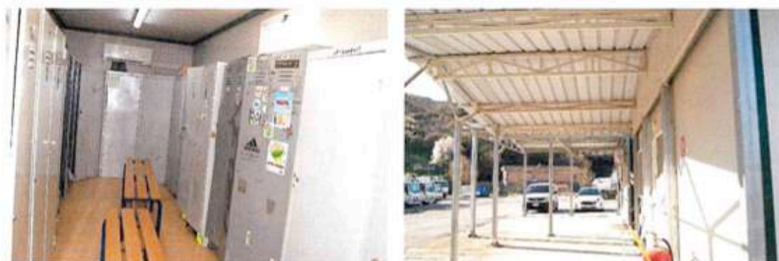
FOTO 16: Vista Spogliatoi E.
