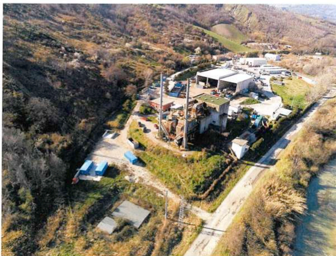
FOTO 1b: Vista aerea del sito in C.da Carapollo.
