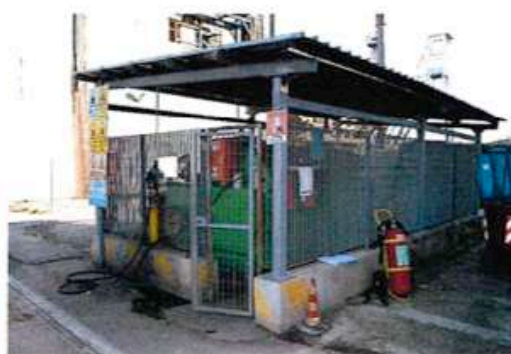
FOTO 10: Tettoia rifornimento carburante.
