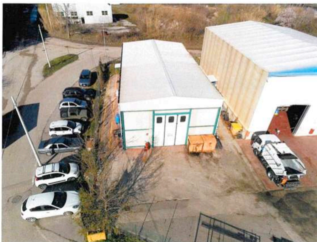
FOTO 19: Vista aerea Magazzino A.
