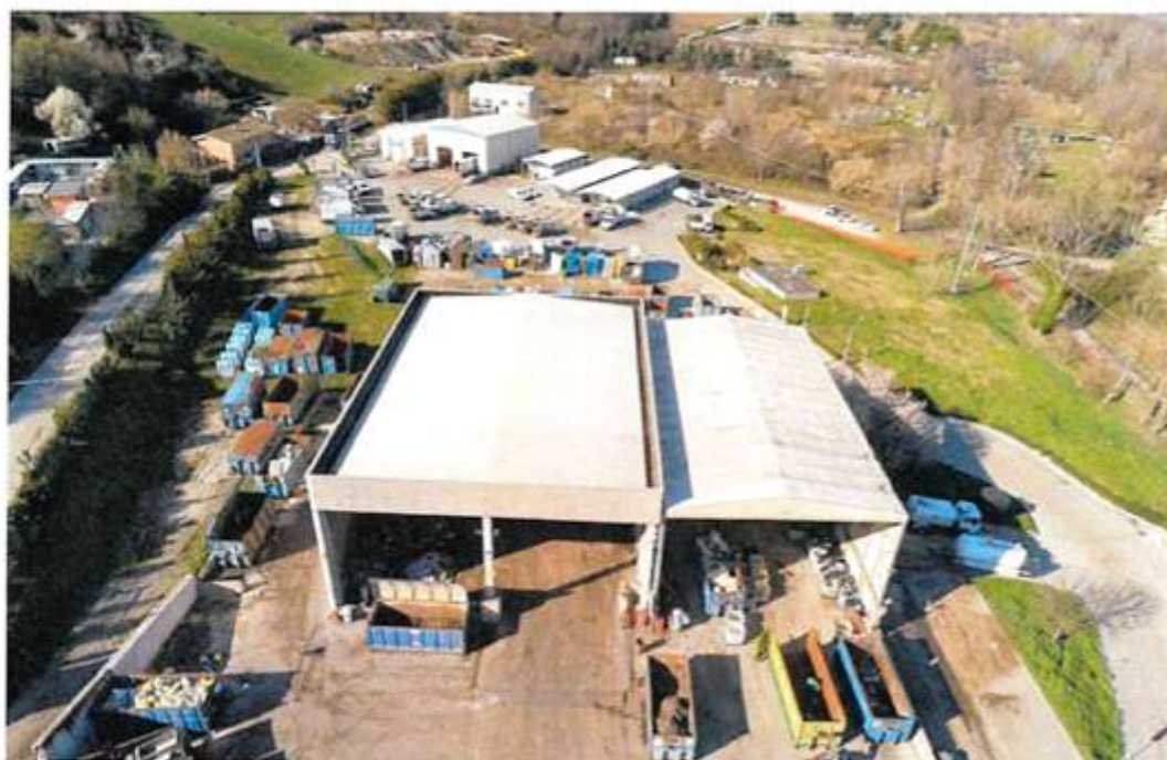
FOTO 5: Capannone prefabbricato N.1 e Tettoia in ACCIAIO e PVC N.2.
