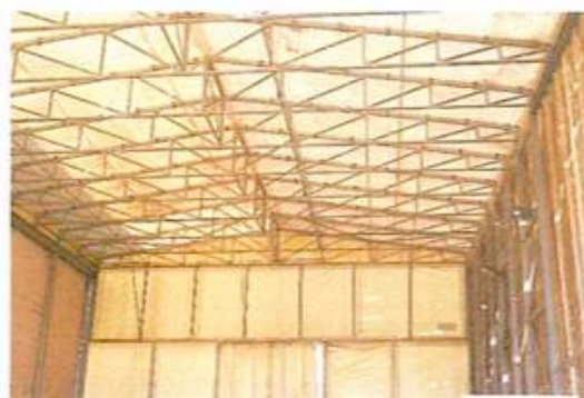
FOTO 8: Interno Capannone N.2
