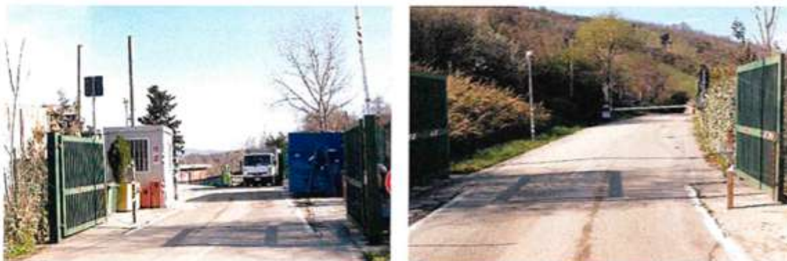
FOTO 4: Postazione di controllo ingresso e ingresso automatico.
