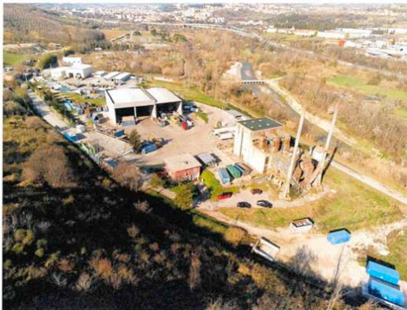
FOTO 6: Vista delle aree verdi, dei piazzali e delle strade.
