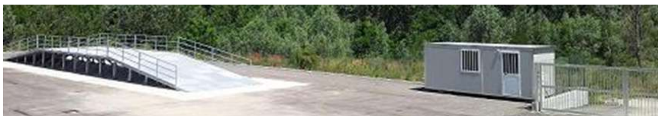
Figura 25: Centro di Raccolta Intercomunale
