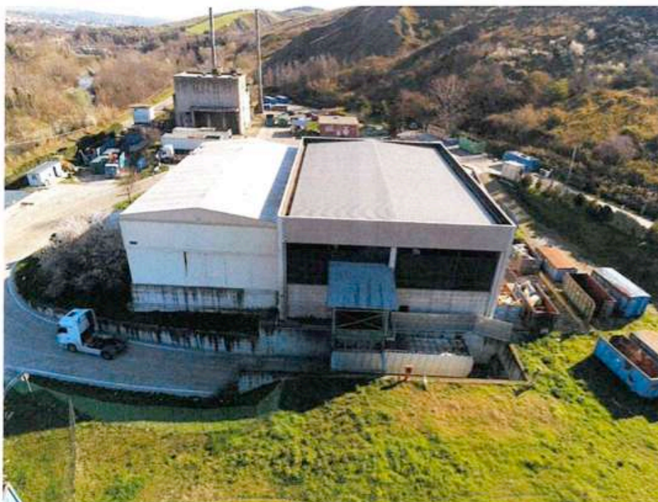
FOTO 6: Capannone prefabbricato N.1 e Tettoia in ACCIAIO e PVC N.2 retro.
