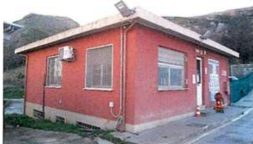
FOTO 9: Fabbricato uffici Pesa N.3.
