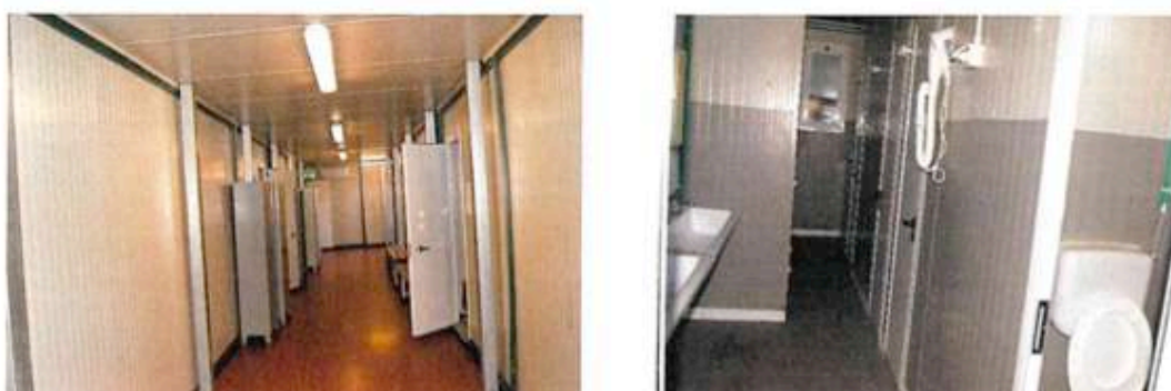
FOTO 15: Vista interna Spogliatoi D.
